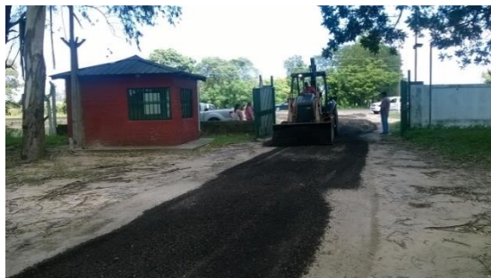
Colocación de reciclado de asfalto. Aporte de Vialidad Nacional.
